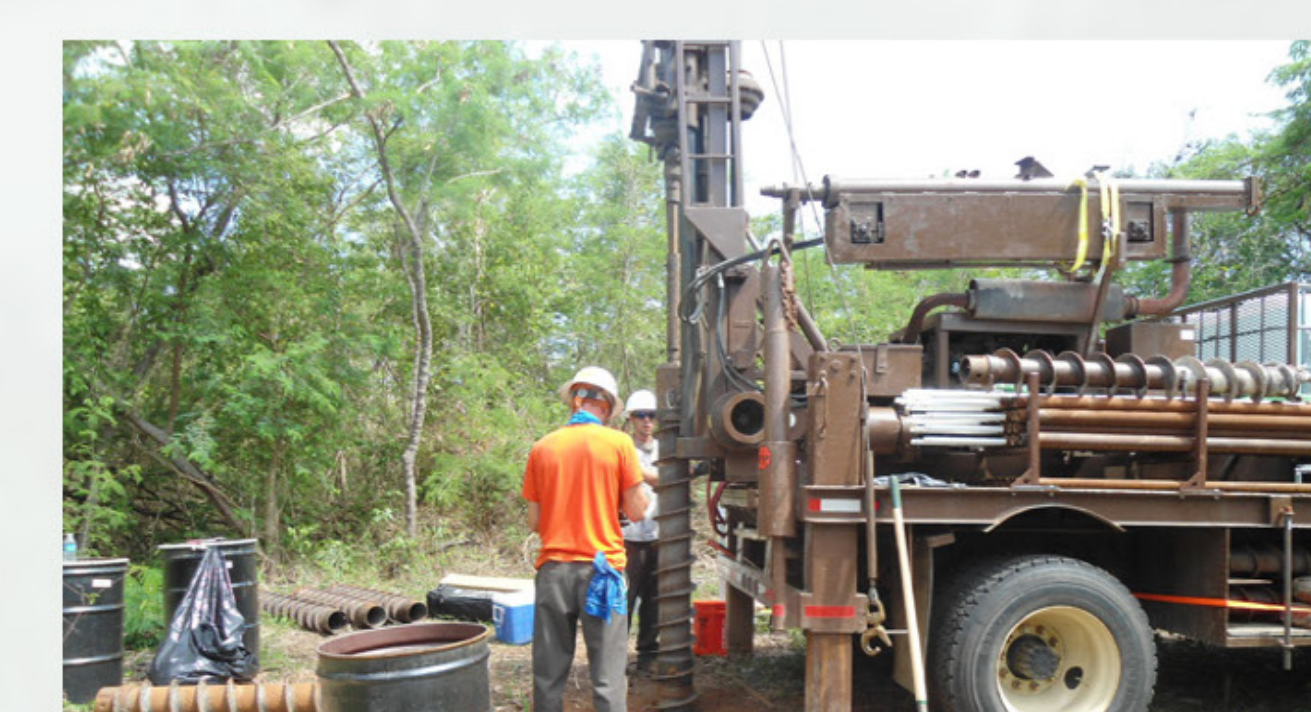
Monitoring well installation / Instalación de pozo de monitoreo
