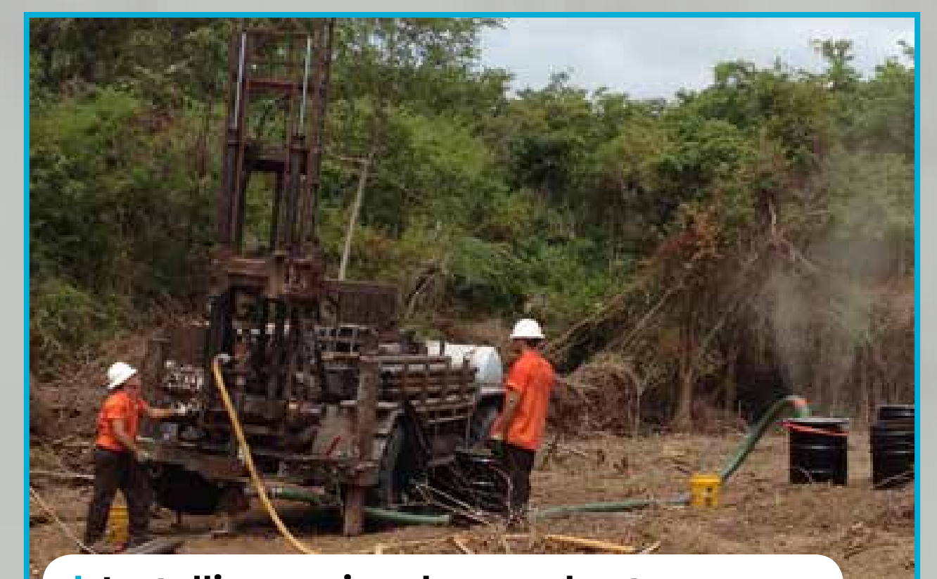
Installing regional groundwater monitoring wells across the VNTR Instalación de pozos de monitoreo de aguas subterráneas regionales en el VNTR
