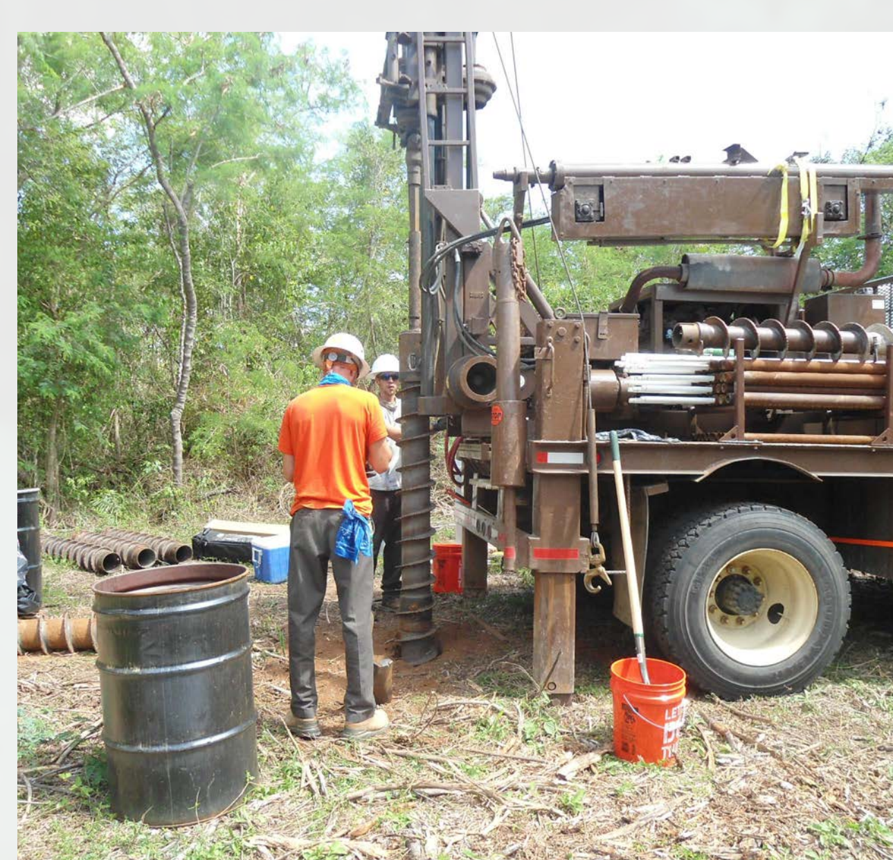
Monitoring well installation / Instalación de pozo de monitoreo
