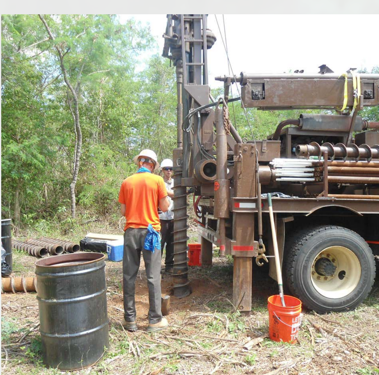
Monitoring well installation / Instalación de pozo de monitoreo
