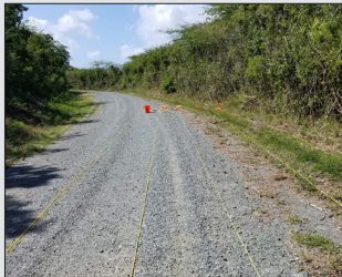
» Transect lines are laid down to guide surface and subsurface munitions removal Se establecen líneas de transecto para guiar la remoción de municiones de la superficie y subsuelo.
