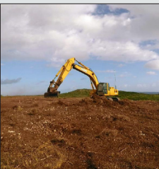
» Remote excavator raking cut vegetation Excavadora remota rastillando vegetación cortada
